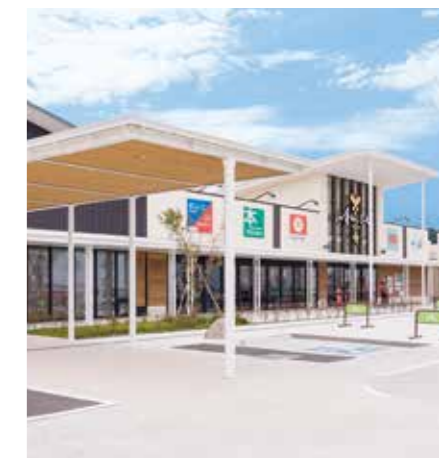
陸前高田市まちづくり(震災復興) 施設名称 アパッセたかた、陸前高田まちなかテラスほか 所在地 岩手県陸前高田市 オープン 2017年より順次開業
